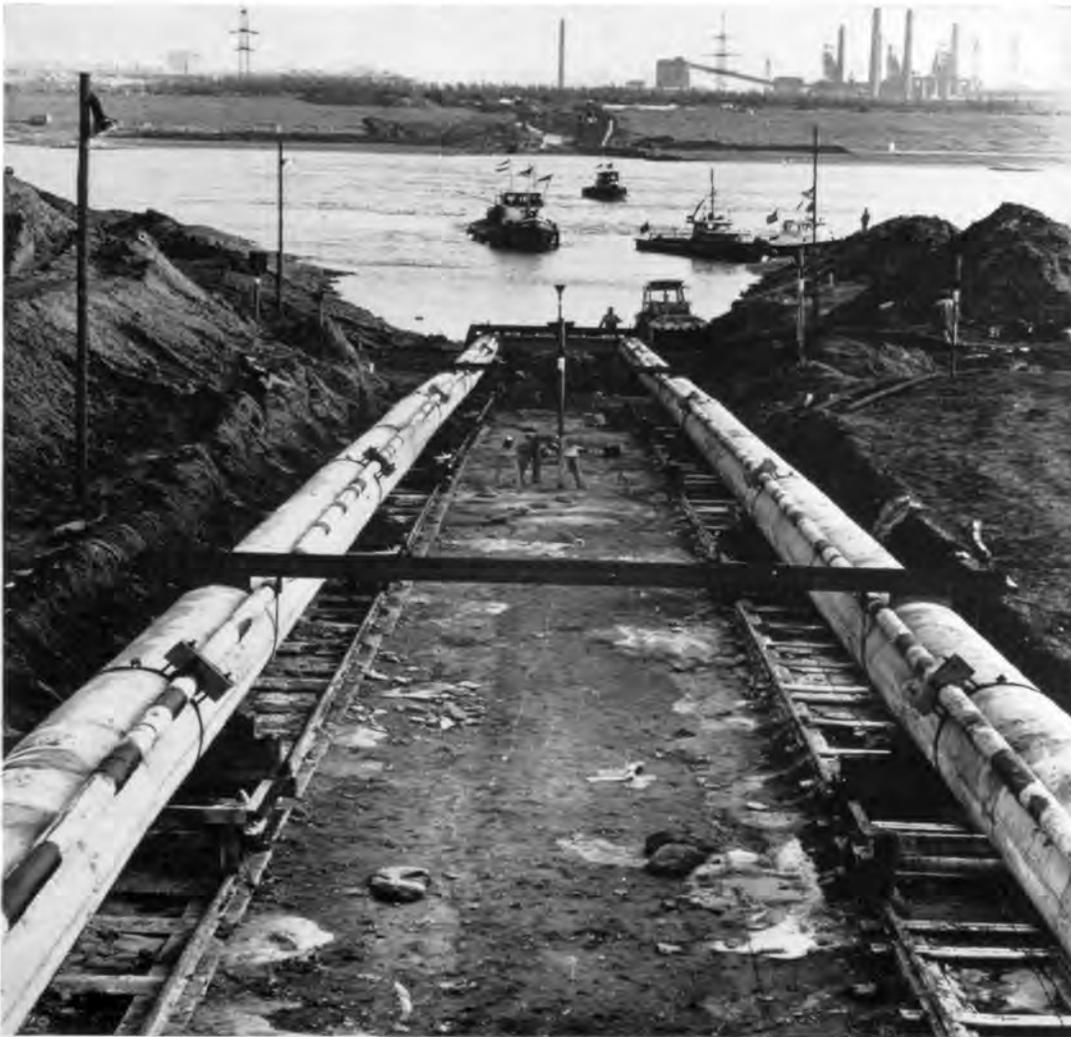
Eine Erdgasleitung unterquert den Rhein bei Duisburg. Die unterirdischen Stränge des Leitungsnetzes sind Transportweg und Transportbehälter zugleich. Aus dem Leitungsnetz nationaler Bedeutung hat sich in den wenigen Jahren der Erdgasversorgung ein international vermaschtes Transportsystem entwickelt. Foto: Thyssengas
