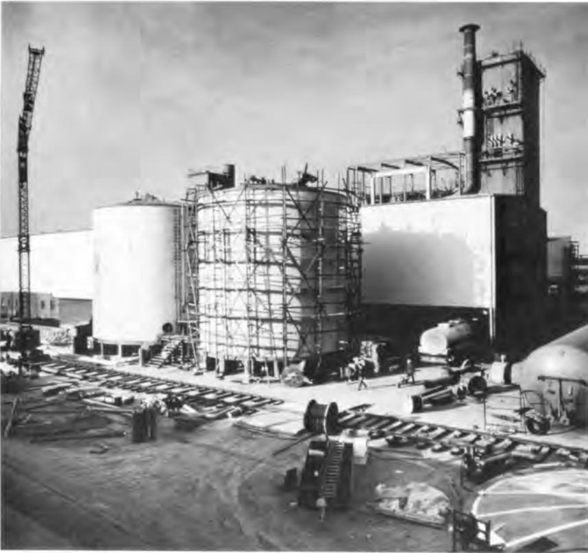
Aufbau und Montage einer Linde-Luftzerlegungsanlage zur Gewinnung von Sauerstoff für die Stahlverarbeitung, Stickstoff und Edelgasen, eines der Arbeitsgebiete der Linde-Werksgruppen für verfahrenstechnische Anlagen.
