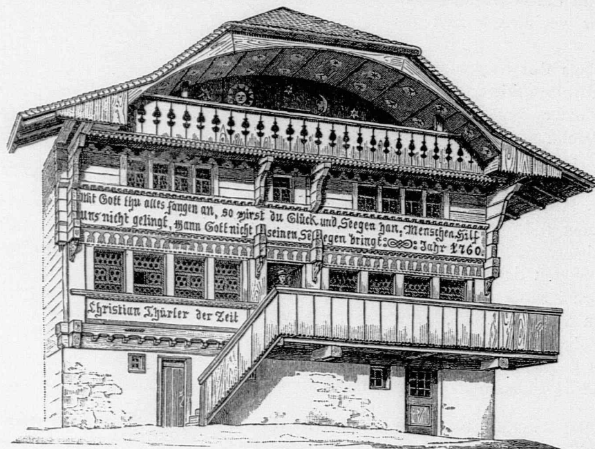
Abb. 32. Kombinierte Block- und Ständerbau.
