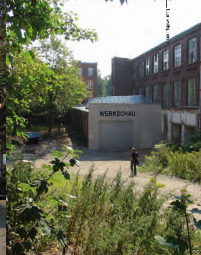
Abb. 78 Hofbereich zwischen Halle 14 und Halle 11
