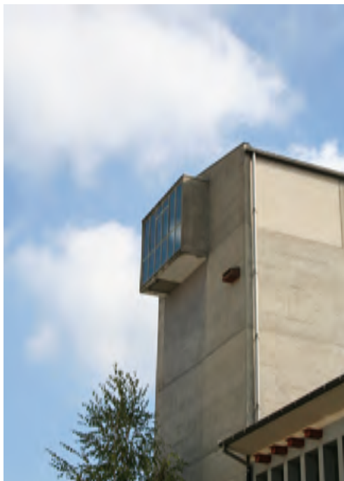
Abb. 128 baulicher Hochpunkt das Silo
