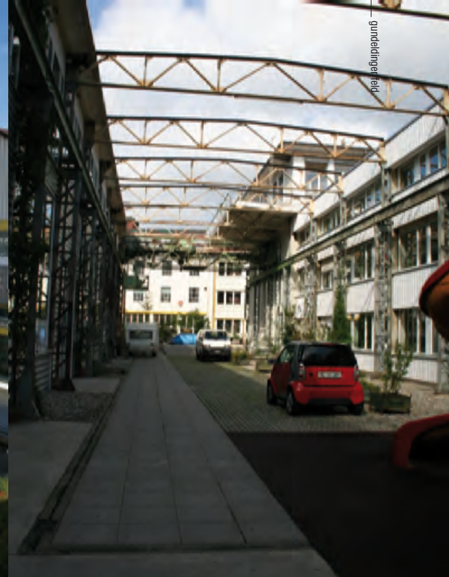
Abb. 127 Hofbereich zwischen Halle 2 und Halle 4/5
