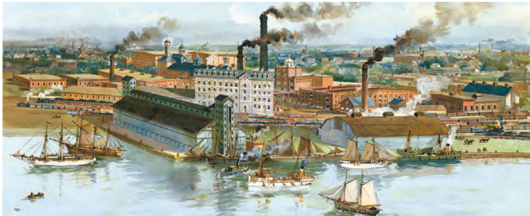
Abb. 205 Distillery District um 1896 mit Bahnanschluss und Lage am Lake Ontario
